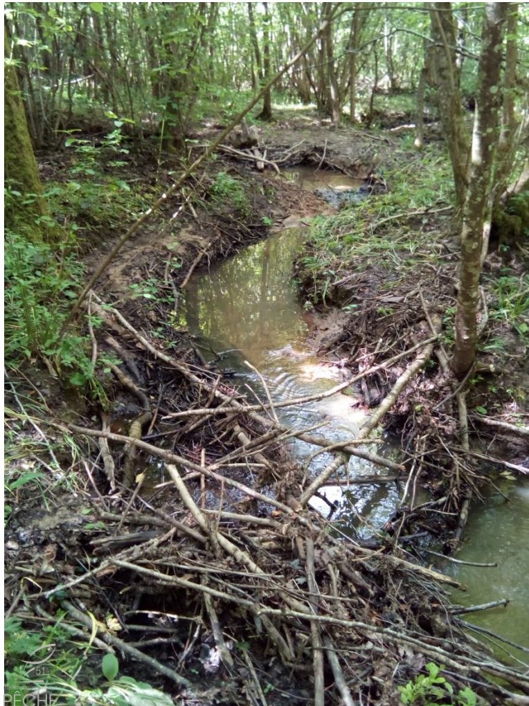
Figure 6 : Embâcles charriés par le cours d'eau lors d'un important évènement pluvieux quelques jours avant l'inventaire
